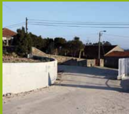
Courel - Construção (1.ª e 2.ª fases) do muro de suporte de terras na Rua de S. Martinho
