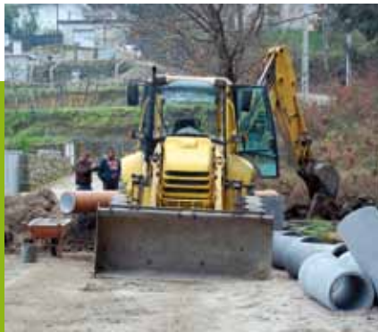
Aborim - Trabalhos de pavimentação da Rua das Mimosas
