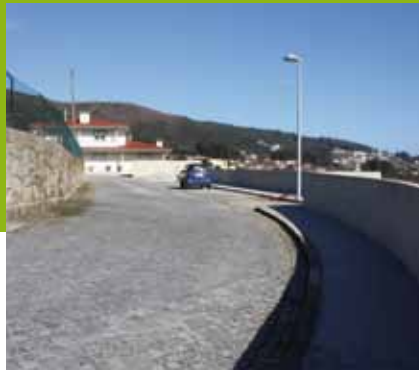
Tamel Stª Leocádia - Muros, portão e vedação em grades de ferro do Jardim-de-Infância
