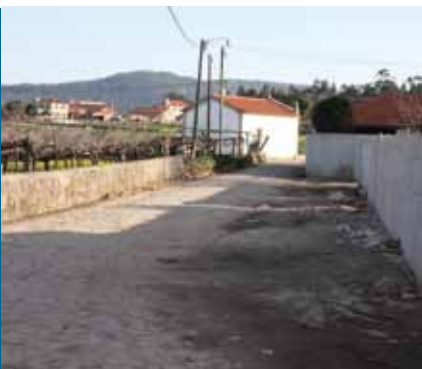
Fornelos - Muro e alargamento da Rua de Santa Comba.
