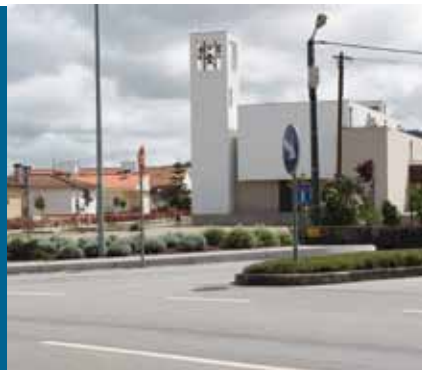
Vila Frescainha S. Pedro - Requalificação dos acessos à nova igreja
