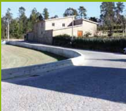
Silveiros - Restauro do piso e coletores de águas pluviais na Rua da Orfa
