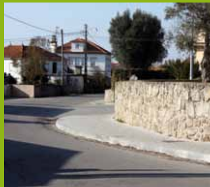
Fragoso - Pavimentação de bermas e passeios na Rua da Agra
