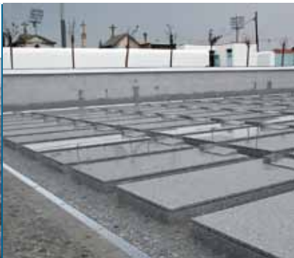
Barcelos - Ampliação do Cemitério Municipal de Barcelos - Pavimentação, floreiras, livros e placagem de jazigos, ossários e gavetões
