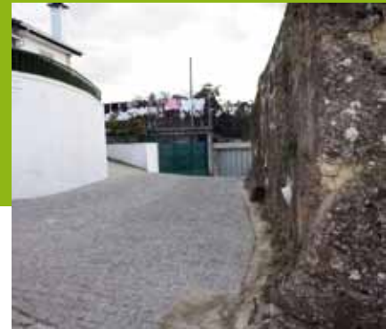
Vilar de Figos - Pavimentação da Travessa da Franqueira e alargamento de rua junto à escola
