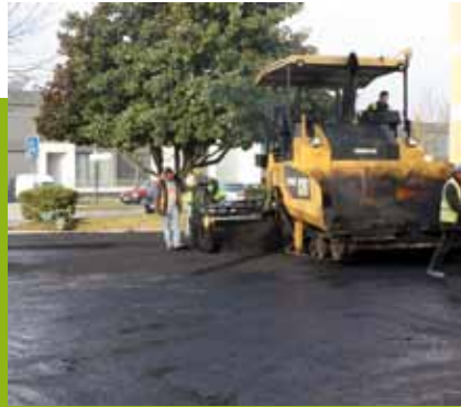
Barcelos - Repavimentação da Praceta António Fogaça e da Urbanização S. José
