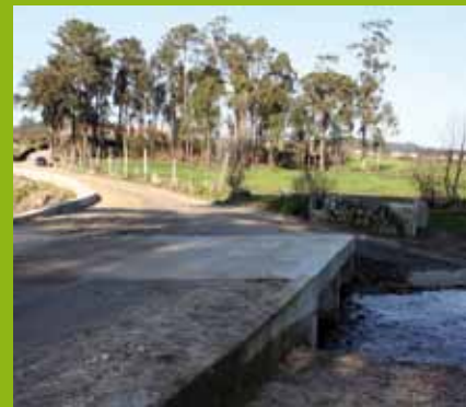
Chorente - Construção de ponte sobre o rio da Baralha e vedação da ponte e terreno
