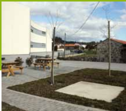
Perelhal - Construção de jardins e espaços verdes
