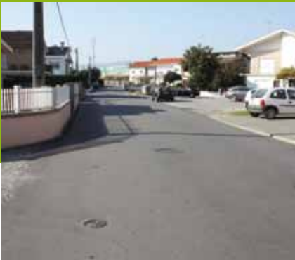
Tamel S. Veríssimo - Repavimentação do piso da Rua J. Castro Gomes e da Rua da Fraternidade
