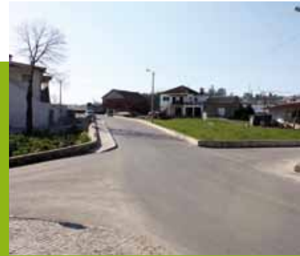
Cambeses - Construção e pavimentação de novo troço da Rua dos Azevinhos
