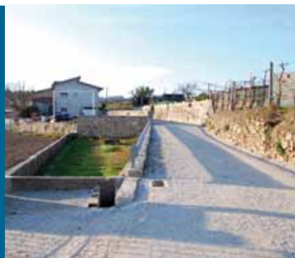
Abade de Neiva - Pavimentação da Rua da Poça do Linhares
