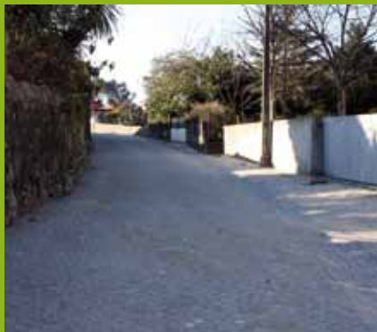
Gilmonde - Pavimentação da Rua de Linhares
