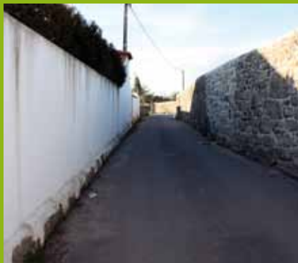
Faria - Pavimentação (1.ª fase) da Rua de Fim de Vila
