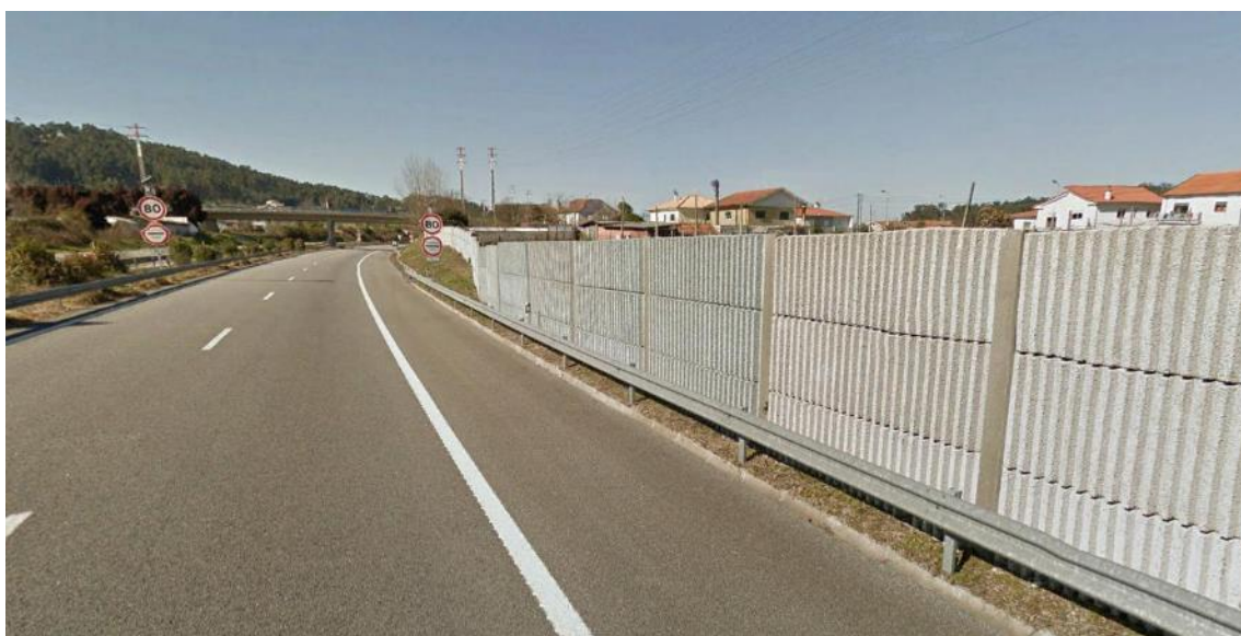
Imagem 3: Barreira de betão
